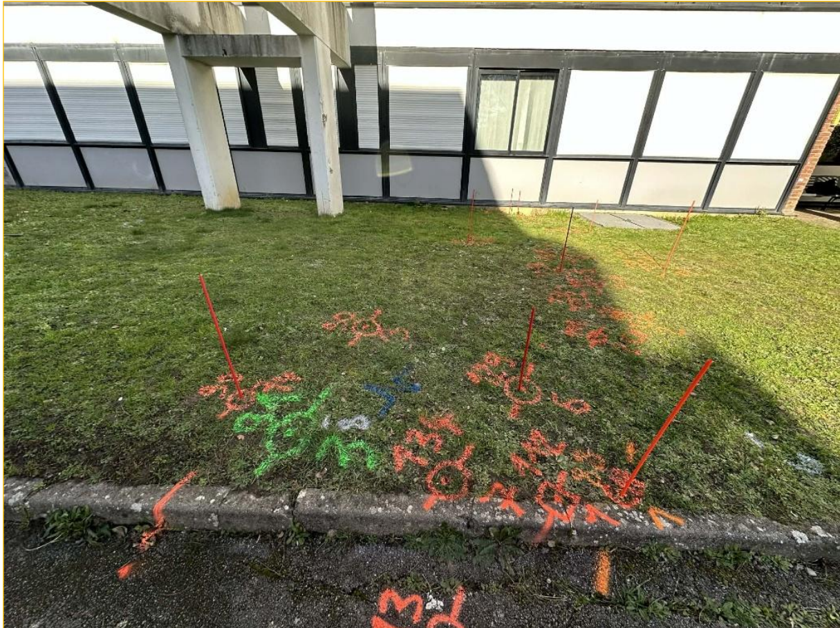
Marquage au sol de la détection
