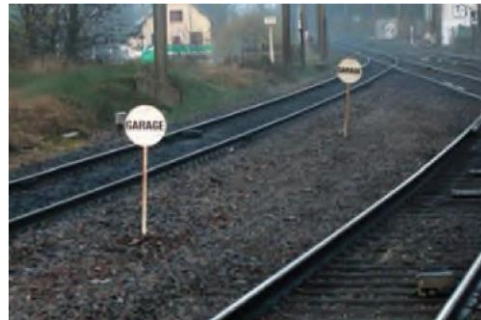
Exemple de pancarte implantée pour les besoins d'un chantier
