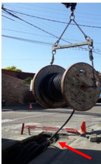
....et sur la tranchée
