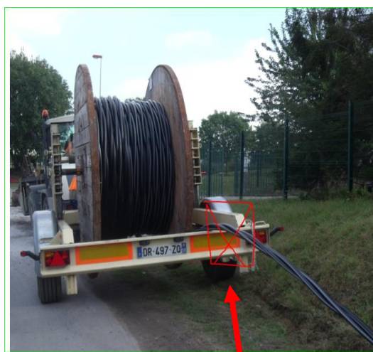
Frottement du câble au niveau de la remorque.....
