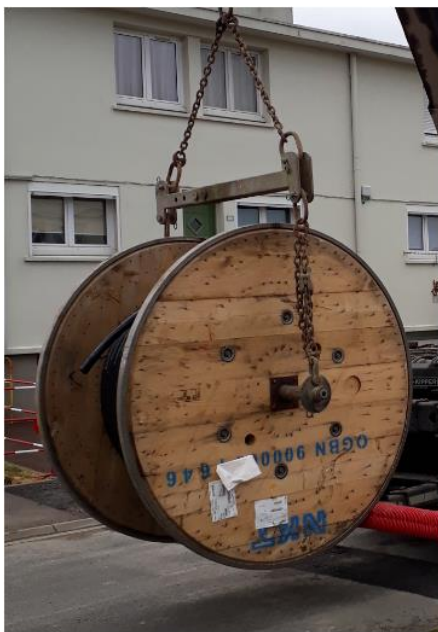
Utilisation d'un palonnier pour la manutention du touret
