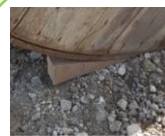
Utilisation de cales pour le stockage du touret
